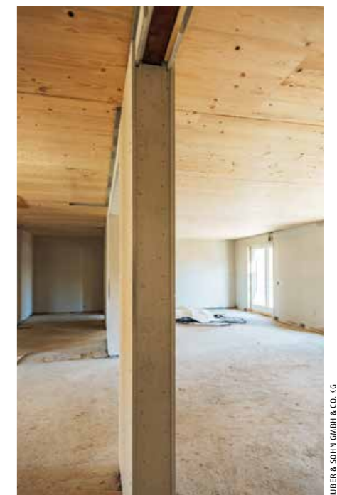
▲ Die tragenden Innenwände und Decken sind ebenfalls als Brettsperrholzelemente ausgebildet
